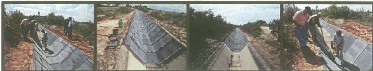
**Alteração de um troço a céu aberto do Distribuidor do Mira para Sifão:** Devido ao deslizamento da encosta e consequente arrastamento do troço do Distribuidor do Mira, na Amieira, foi necessário efectuar um bypass de emergência, situação que foi solucionada através da construção de um sifão.
