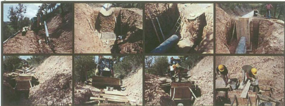
**Construção de um descarregador no Distribuidor da Boavista dos Pinheiros:** Na terminal do distribuidor da Boavista dos Pinheiros foi construído um descarregador lateral para manter o nível constante a montante e permitir em situação de emergência a descarga através do sifão Nyerpic. Esta obra visa essencialmente regular as descargas do sifão Nyerpic que causavam danos no caminho da Fiurinha.
