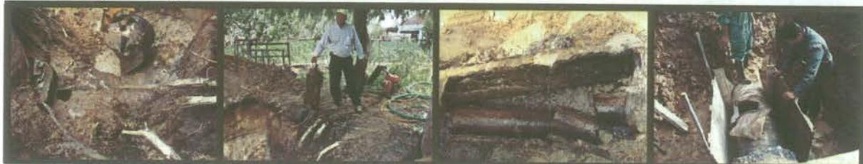
O número de espaldas partidas que foram reparadas foi anormalmente elevado este ano, situação que se generalizou um pouco por todo o aproveitamento mas com maior incidência no Canal Condutor Geral, no Distribuidor das Craveiras, no Distribuidor dos Nascedios e no Reservatório de Odeceixe.
