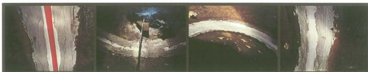
**Estabilização da encosta e reconstrução do CCG:** O colapso da encosta originou o arrastamento das espaldas da margem esquerda junto ao vértice 138/2 e 138/3. Para proceder à estabilização da encosta foi necessário movimentar as terras para dentro do canal e serem retiradas para a margem oposta. Foram utilizadas uma máquina de rastos 140Hp e uma máquina giratória. Seguidamente procedeu-se à reconstrução das 7 espaldas do CCG.
