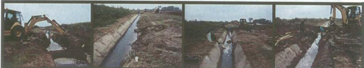
**Figura 5:** Reconstrução de espaldas no Canal Condutor Geral
