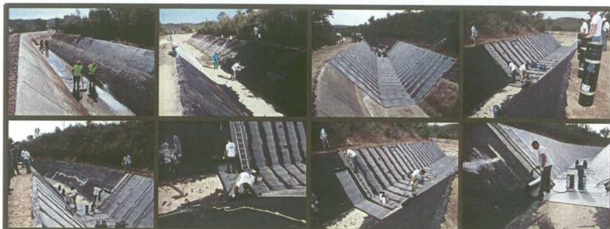
**-Distribuidor do Mira:** Foi substituída a tela de PVC por tela asfáltica entre o vértice 62 e o vértice 64 e ainda entre o vértice 75 e 77.
