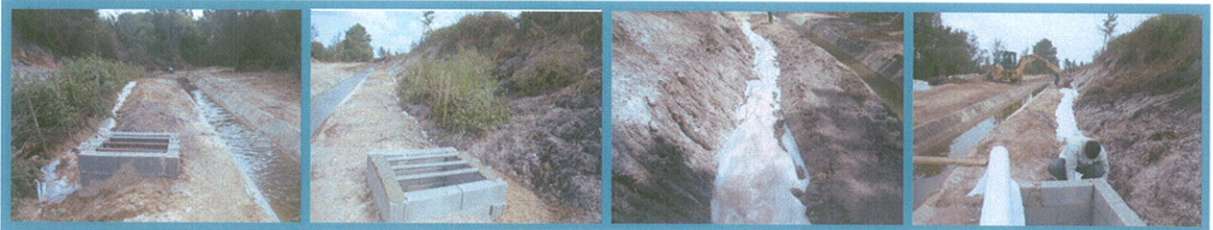
Figura 7: Construção de aqueduto e drenos no Distribuidor da Lenha Mancosa
