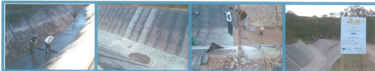
Figura 3: Impermeabilização com tela asfáltica – Canal Conductor Geral
