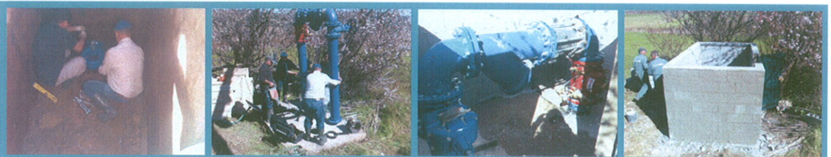
Figura 8: Colocação de redutor de pressão na Várzea de Odeceixe
