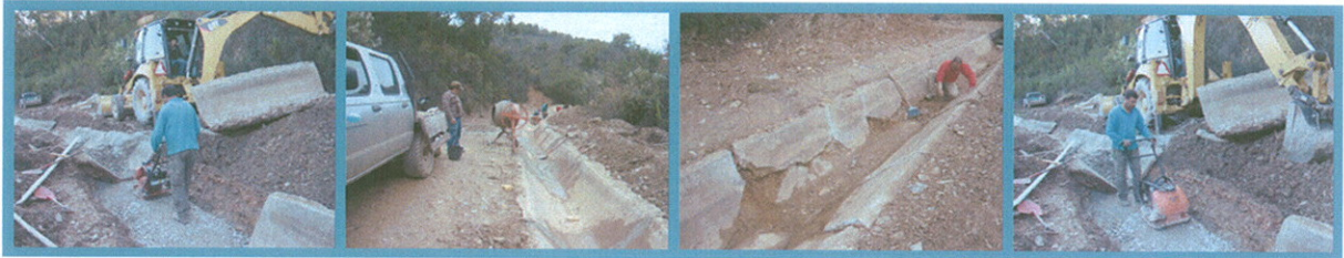
Figura 6: Reconstrução do Distribuidor do Mira
