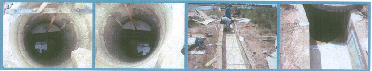
Figura 11: Colocação de caixilho e Construção de Caleira da Regadeira 55 no Canal de Milfontes
