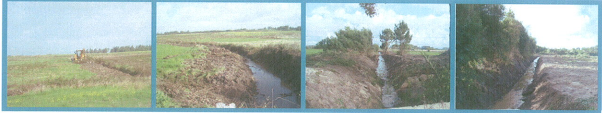
Figura 9: Rede de colectores do Bloco XI após a limpeza e reperfilamento
