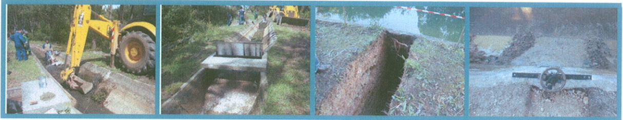
Figura 10: Limpeza do Distribuidor da Azenha e Construção de Descarga de Fundo no Canal de Odeceixe
