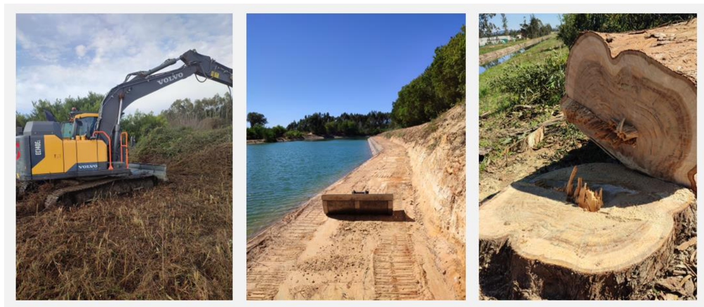
Fotos 1. Trabalhos de limpeza das infraestruturas do AHM
