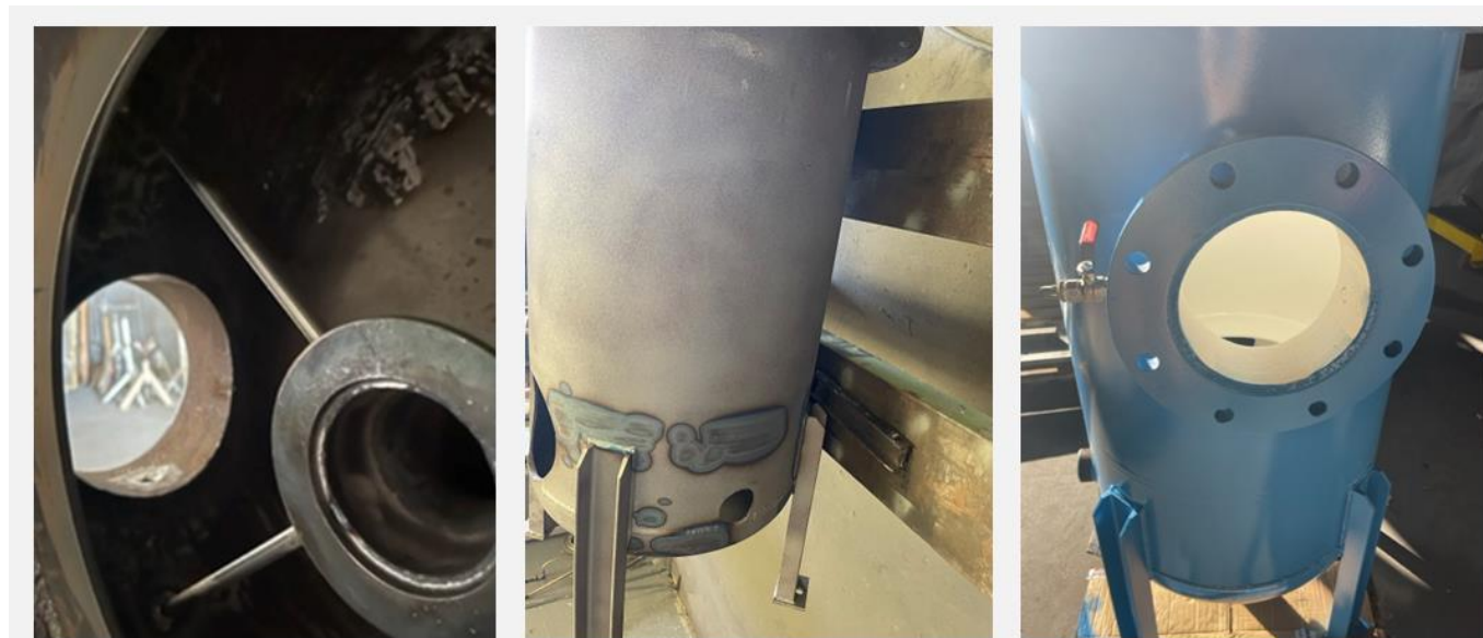
Fotos 7. Reparação dos filtros
