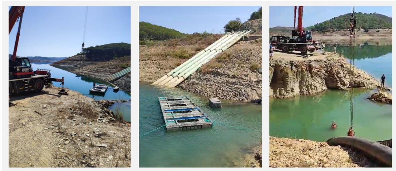
Fotos 9. Adaptação da estação elevatória existente
