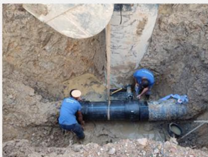
Fotos 2. Reparação de roturas
