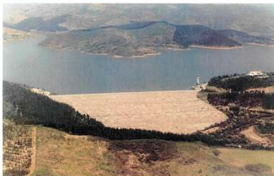
Figura A.1.4 – Vista geral sobre a barragem e albufeira do Santa Clara (Fonte: portal INAG – Barragens de Portugal)
