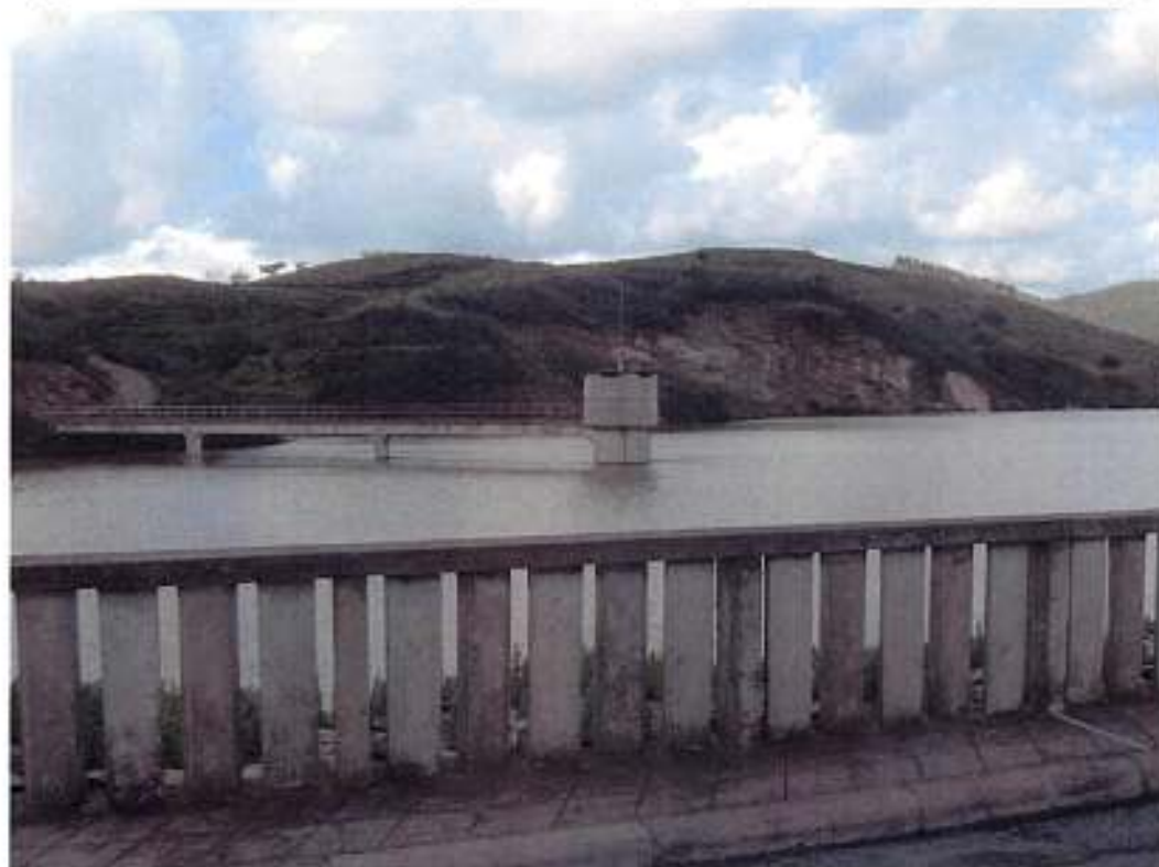
Figura A.I.15 – Tomada de água da barragem do Corte Brique (Fonte: portal INAG – Barragens de Portugal)
