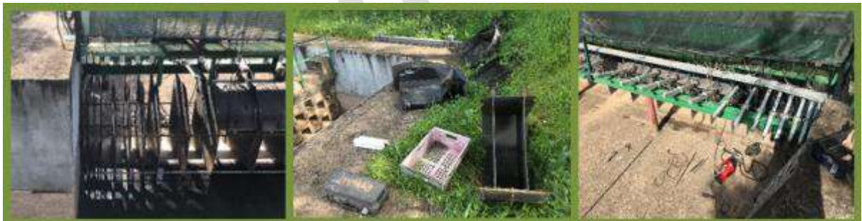
Figura 3: Reparação do módulo de admissão ao Canal Condutor Geral
