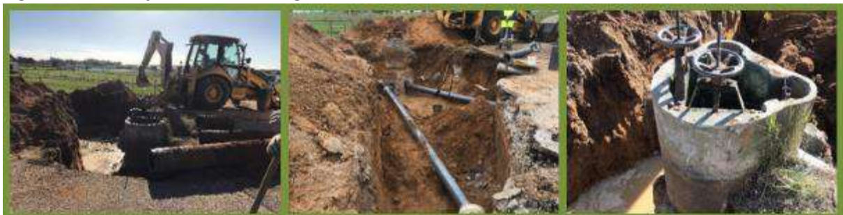
Figura 4: Deslocação de caixa de rega na Boavista dos Pinheiros
