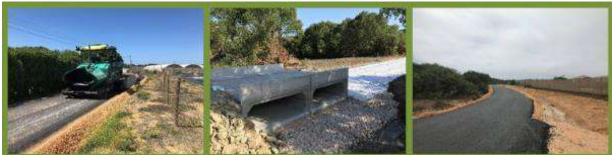
Figura 5: Empreitada de substituição de regadeiras no Aproveitamento Hidroagrícola do Mira
