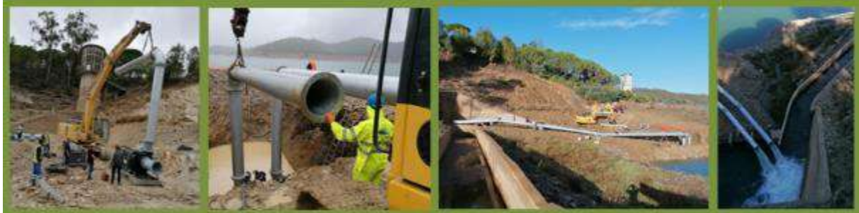
Figura 2: Montagem da Bombas
