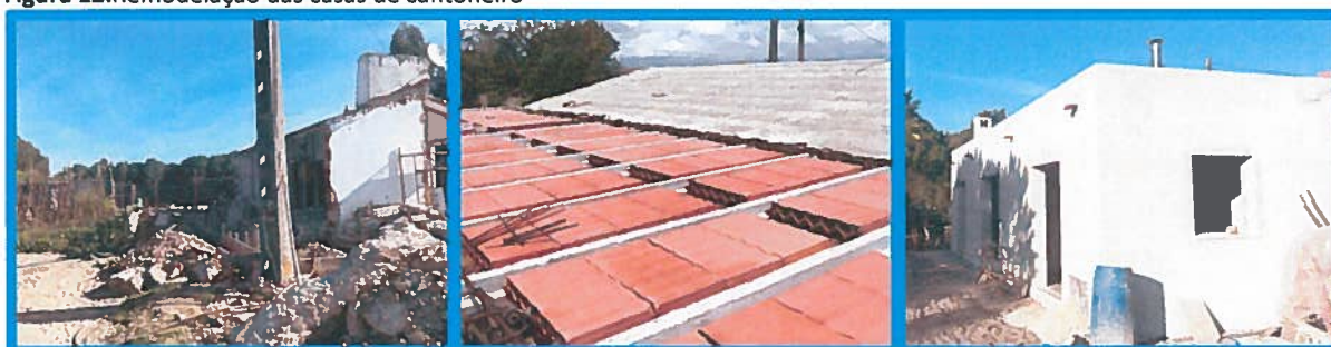
Figura 12: Remodelação das casas de cantoneiro
