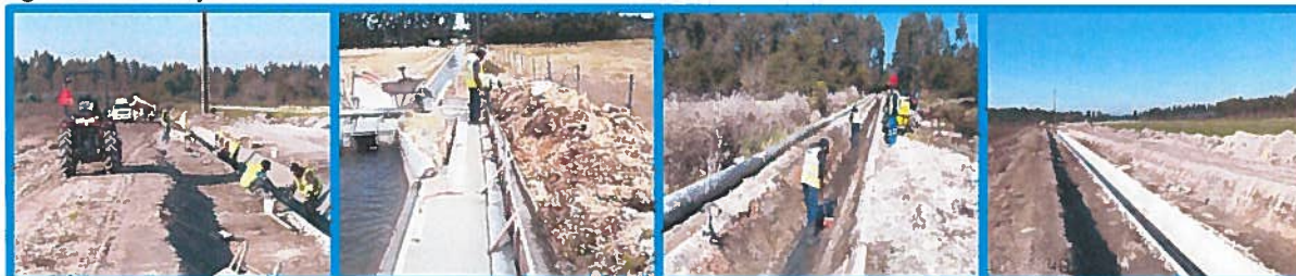
Figura 2: Reabilitação do Distribuidor dos Nascedios
