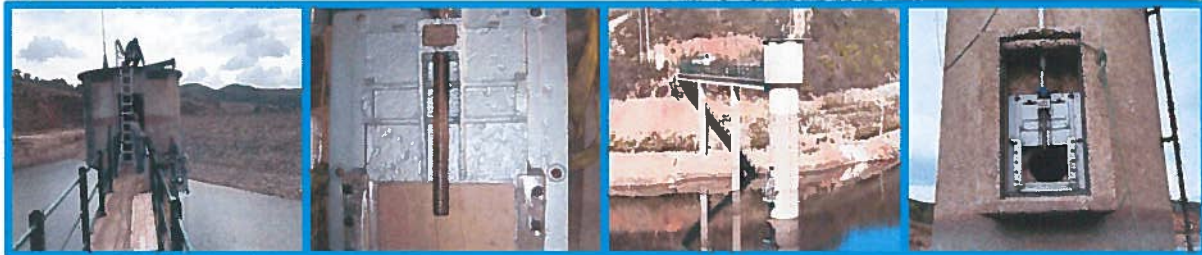
Figura 8: Reparação da comporta
