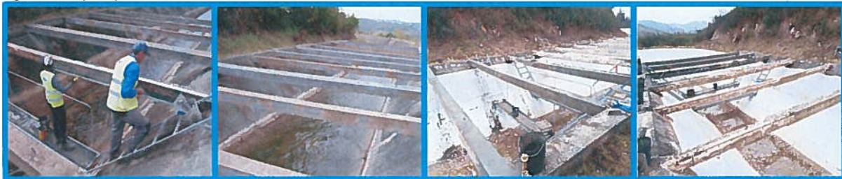
Figura 5: Reparação dos tirantes do Canal Condutor Geral
