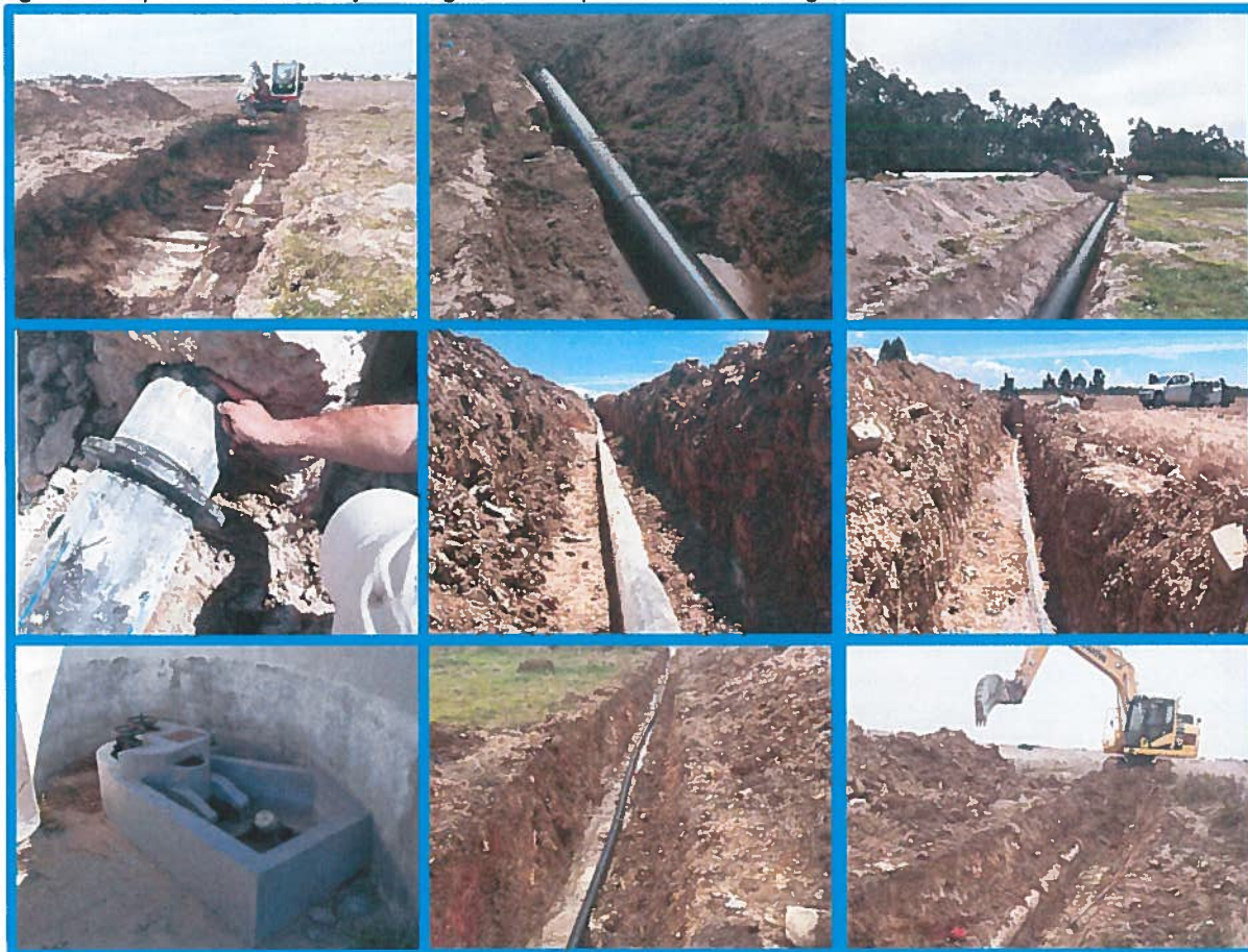
Figura 11: Empreitada de substituição de regadeiras no Aproveitamento Hidroagrícola do Mira
