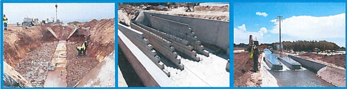
Figura 4: Construção do descarregador
