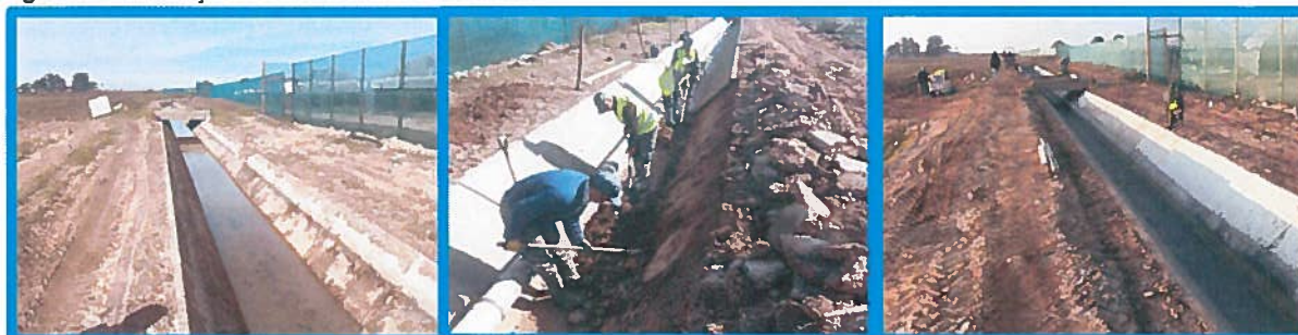
Figura 3: Reabilitação do Distribuidor das Courelas
