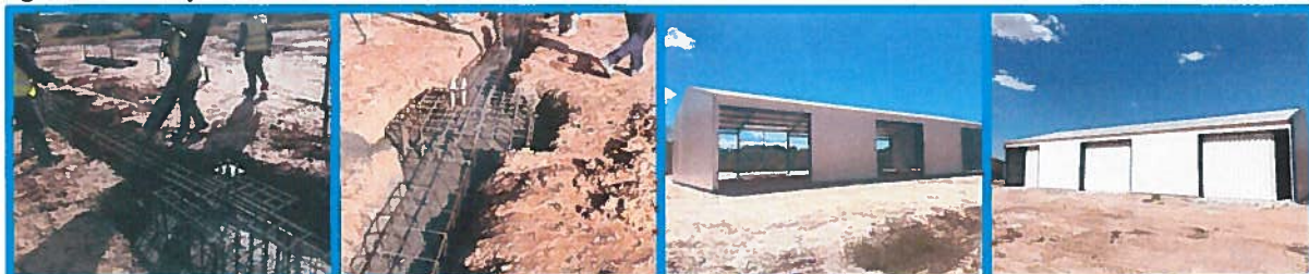
Figura 6: Construção do armazém
