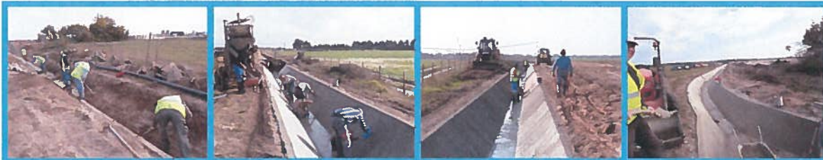
Figura 5: Reconstrução do Distribuidor do Brejo Redondo
