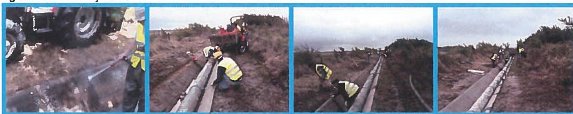
Figura 7: Reconstrução do Distribuidor dos Nascedios
