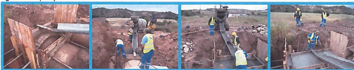
Figura 13: Reparação no sifão de Telhares
