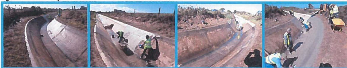
Figura 6: Reconstrução do Distribuidor das Craveiras
