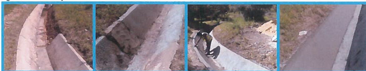
Figura 9: Reconstrução do Distribuidor do Mira
