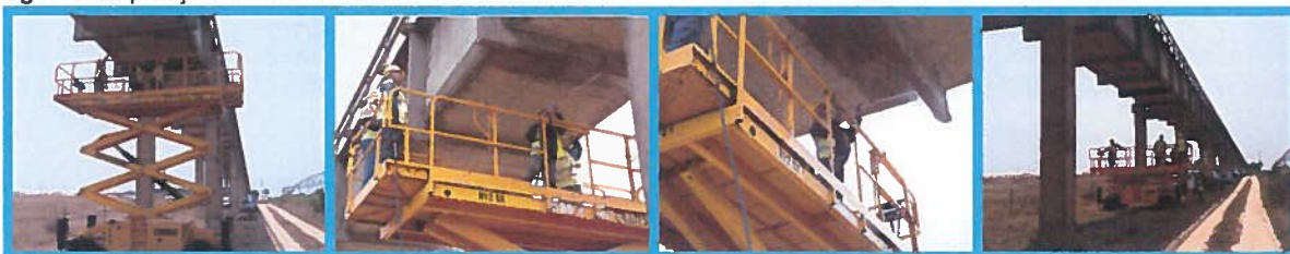
Figura 4: Reparação da Ponte Canal do Canto
