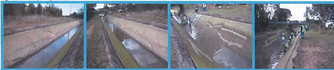
Figura 10: Reparação de Fissuras no Canal de Milfontes
