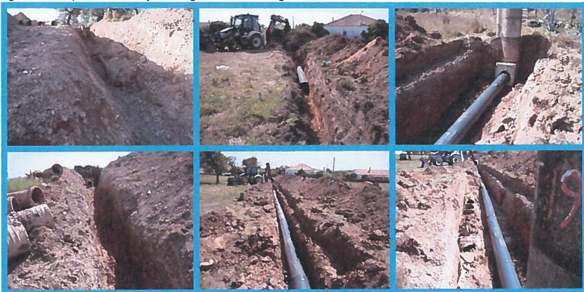
Figura 3: Exemplo da substituição de regadeiras com tubagem de PVC
