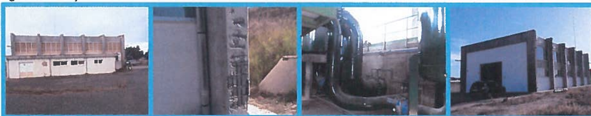
Figura 11: Estação Elevatória do Bloco XI
