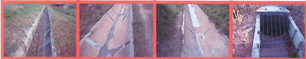
Figura 2: Reconstrução do Distribuidor do Mira
