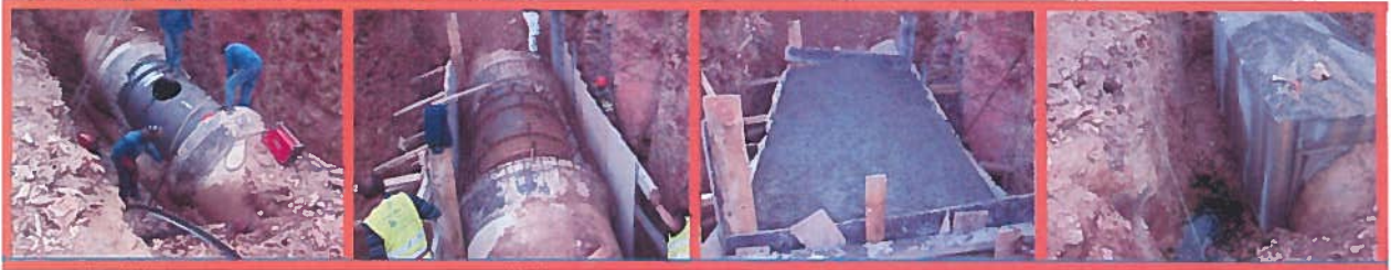
Figura 6: reparação do Sifão da Baiona
