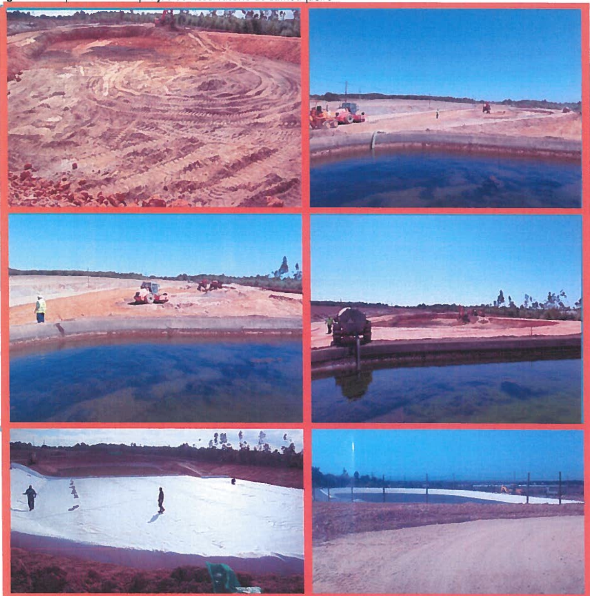
Figura 11: Empreitada de Ampliação do Reservatório do Samouqueiro
