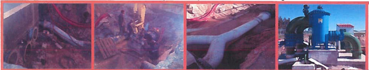
Figura 10: Empreitada de construção do sistema de filtragem na Estação Elevatória do Bloco de Rega XI
