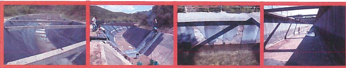
Figura 5: Impermeabilização de troços no Canal Conductor Geral
