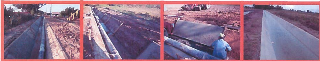
Figura 3: Reconstrução do Distribuidor das Craveiras
