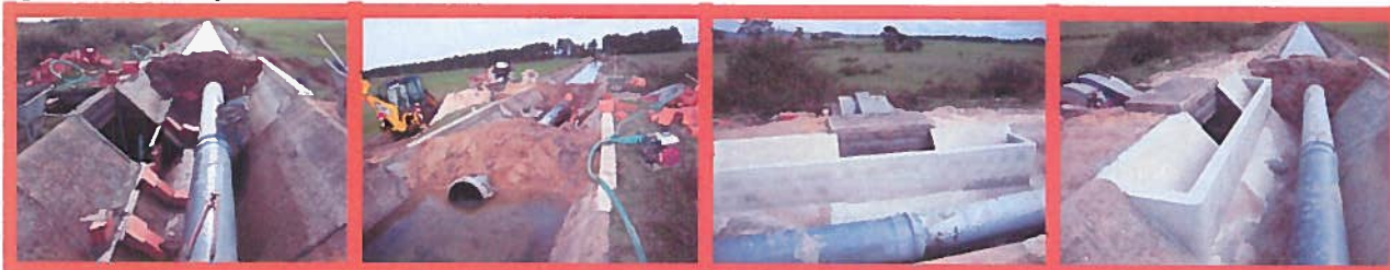
Figura 4: Reconstrução do Distribuidor dos Nascedios
