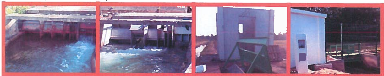
Figura 14: Empreitada de automação dos módulos
