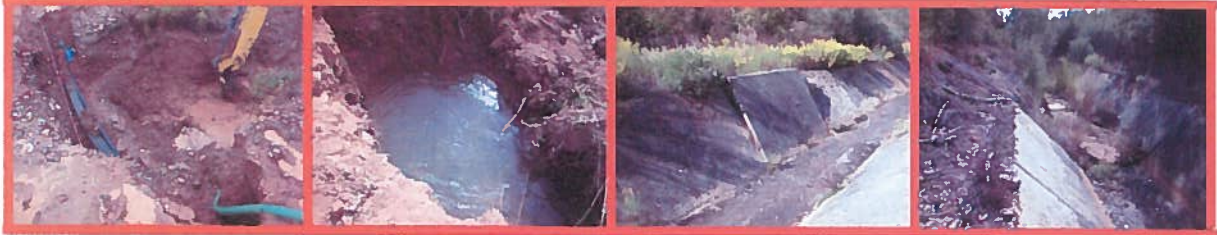
Figura 8: Vala de descarga do sifão de Telhares
