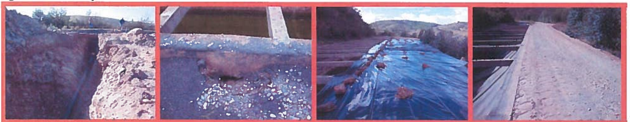
Figura 7: Estabilização do aterro dos Barreirinhos
