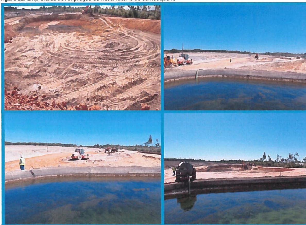
Figura 12: Empreitada de Ampliação do Reservatório do Samouqueiro
