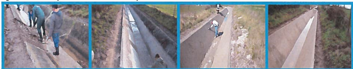
Figura 4: Reconstrução do Distribuidor do Cabeço Queimado
