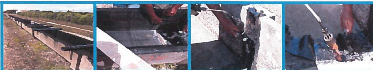
Figura 8: Colocação de tela no Distribuidor do Malavado
