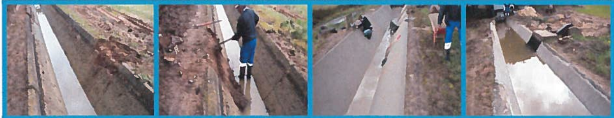
Figura 2: Reconstrução do Distribuidor da Asseiceira
