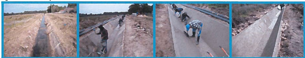
Figura 5: Reconstrução do Distribuidor das Craveiras
