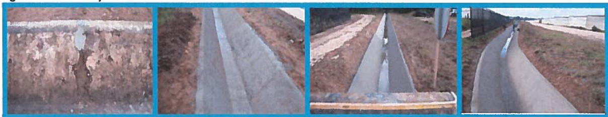
Figura 3: Reconstrução do Distribuidor da Azenha
