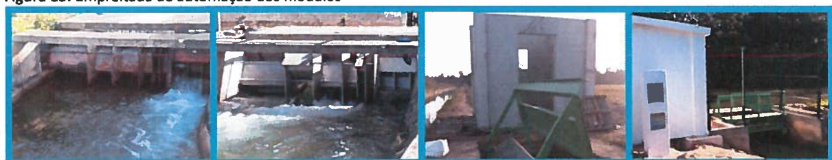
Figura 15: Empreitada de automação dos módulos
