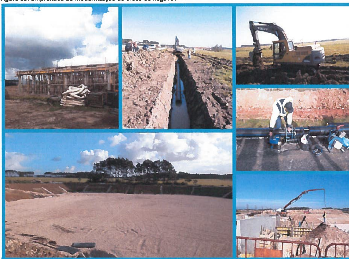
Figura 13: Empreitada de Modernização do Bloco de Rega XIV
