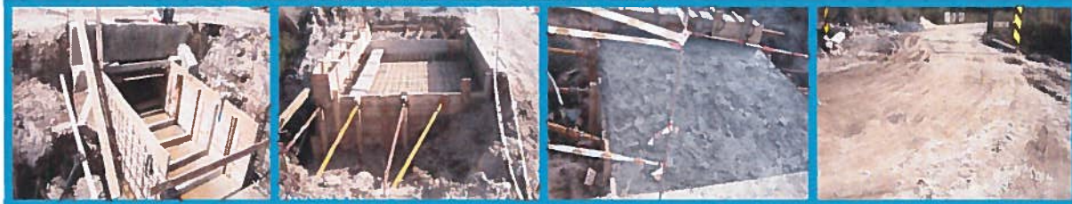
Figura 10: Reconstrução com alargamento de pontão no colector da Alcaria
