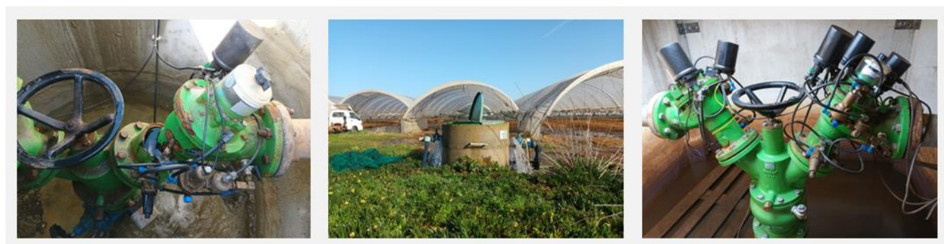
Figura 10. Manutenção da rede de rega em pressão (Bloco XI)
