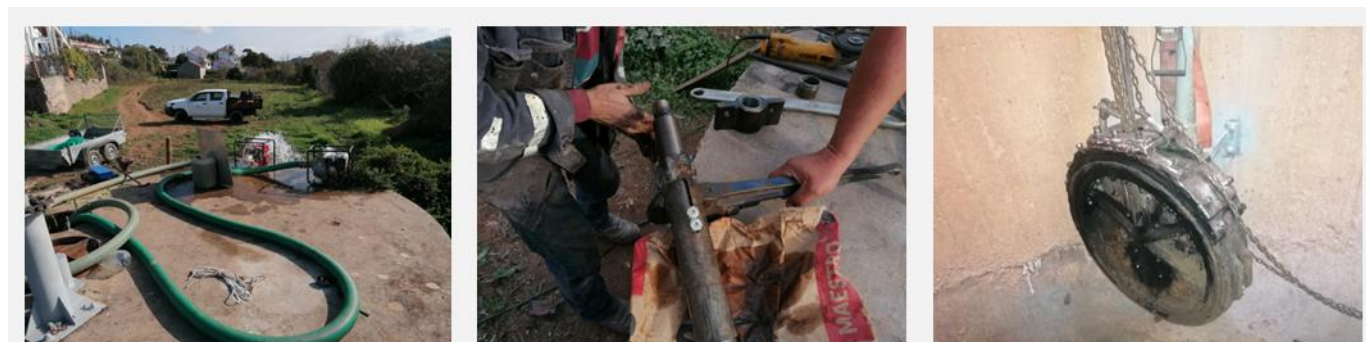
Figura 11. Manutenção da rede de rega em pressão (Bloco XI)
