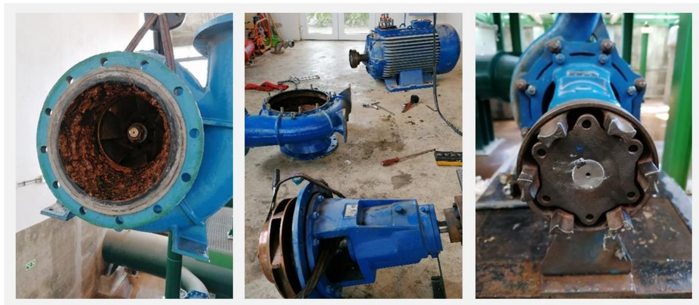
Figura 9. Manutenção dos grupos da E.E. Alcaria (Bloco XI)
