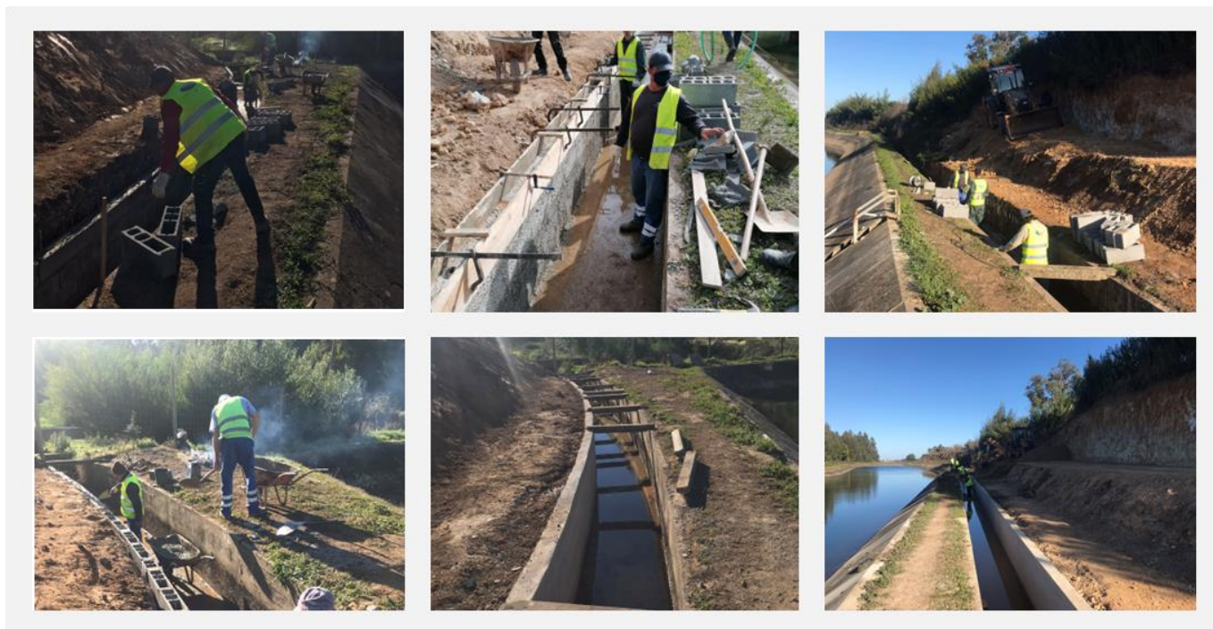
Figura 3. Reparação do distribuidor
