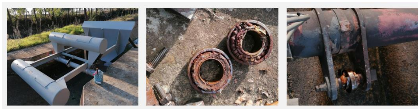
Figura 4. Reparação de comportas
