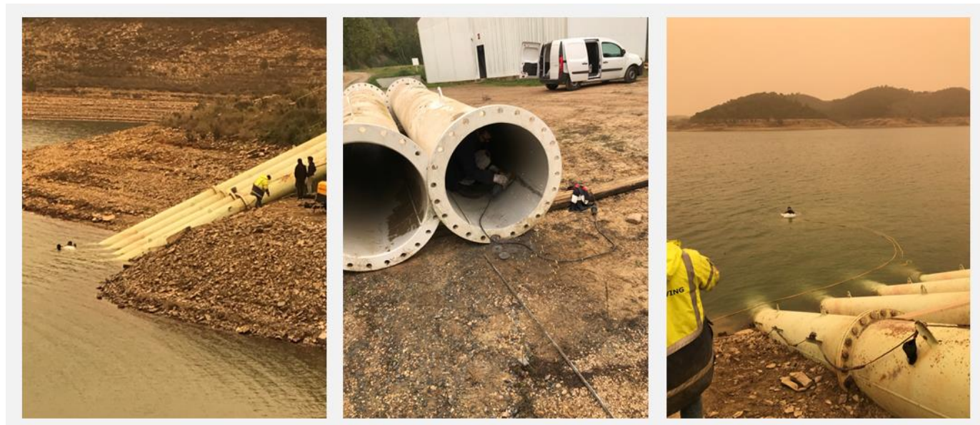
Figura 7. Trabalhos de prolongamento da EE Santa Clara
