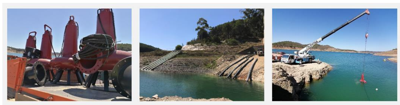
Figura 8. Instalação de grupos submersíveis (Santa Clara)
