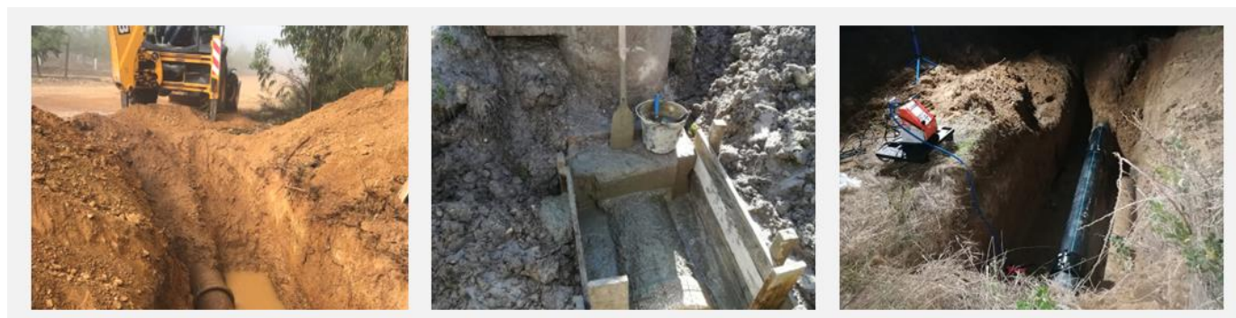
Figura 2. Reparação de roturas
